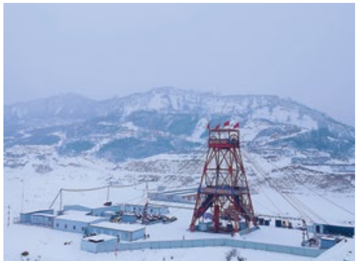
▲ 王家岭矿东翼工业场地项目施工现场
